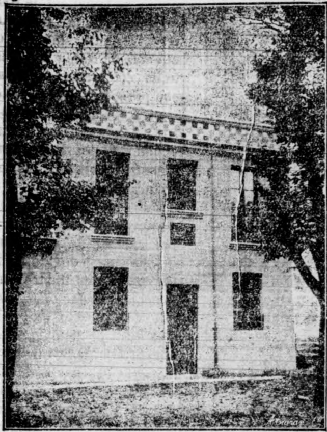
Construcción hecha en Logroño para nuestra asociada doña Isidora Villasejo que será amortizada en 30 años
