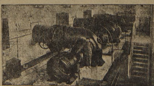
Interior de máquinas de la primera elevación
