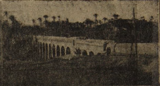
Tercer canal transversal Sifón sobre el río Vinalopó en Elche
