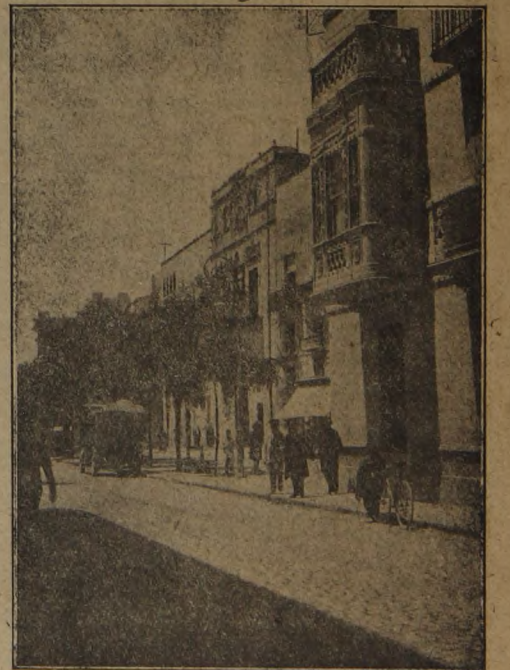
Entrada a la Plaza Mayor, por el Puente de Canalejas
