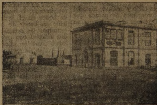
Estación transformadora de Crevillente
